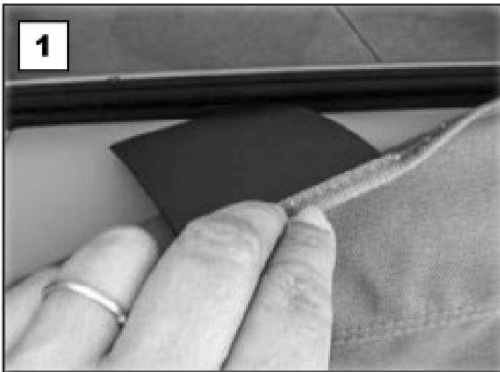
1 Conecte el plástico al marco de la puerta
